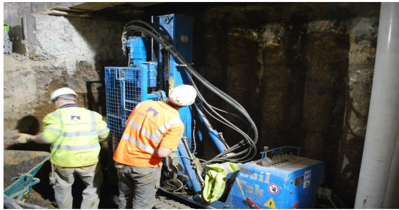
Fig 8: Restricted access mini piling rig
