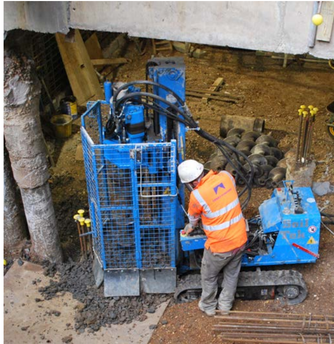
Figure 14. Restricted access mini piling rig
